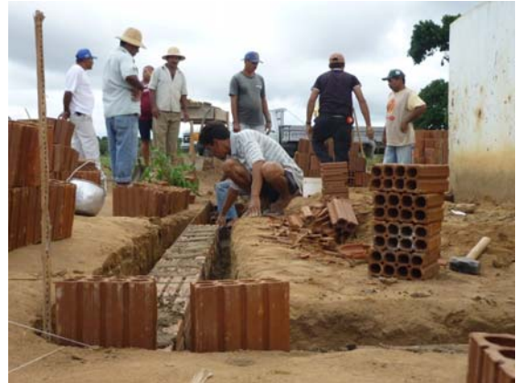
Die Maurer bei ihrer Arbeit: Hier entsteht das Fundament für die neuen Außenwände
