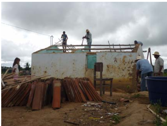
Die Freiwilligen beim Abdecken des Daches
