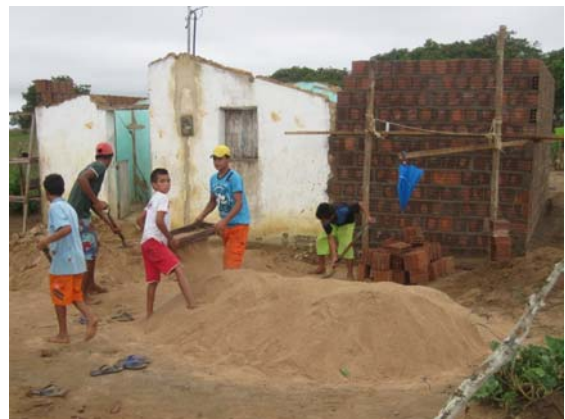
Selbst die Kinder helfen mit: hier beim Sieben des Sandes für den Mörtel
