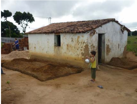
Die Hütte von Marcio vor Beginn der Selbsthilfeaktion: links ist der Grundriss der zwei neuen Räume und rechts der geplanten Toilette zu sehen
